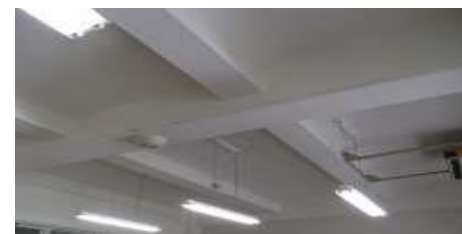
【執務室の天井】
