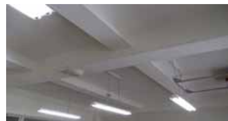
【執務室の天井】
