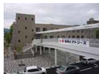
2階 屋外デッキ
