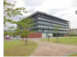
庁舎外観（南西側）
