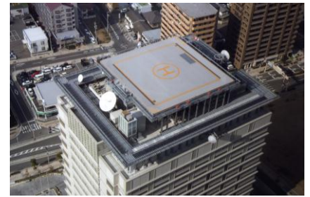
【事例：ヘリポートの設置】
