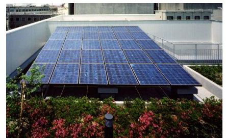
【事例：太陽光パネルの設置】
