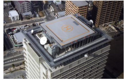
【事例：高松市 ヘリポートの設置】
