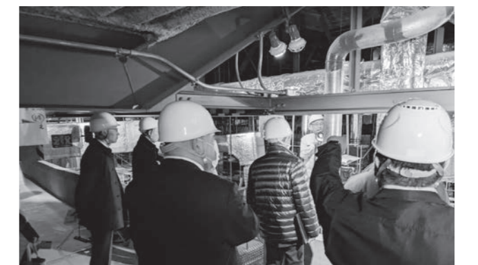
つり天井裏の様子
