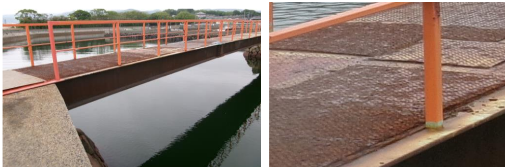
写真3-1 補修事例（管理橋の転落防止柵の塗替え、床面の当て板補修）
