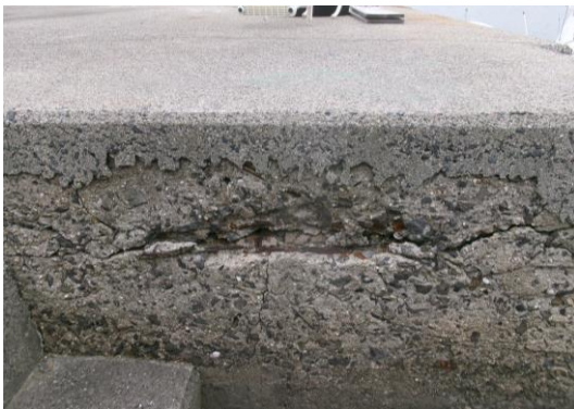
写真2-2 コンクリート構造物の鉄筋露出 写真2-3 構造物の沈下
