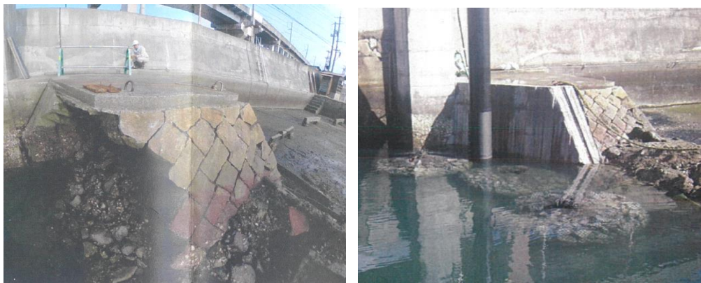
写真3-3 補修事例（導流堤の部分崩壊と対策工）
