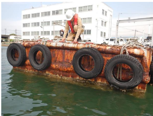
写真2-4 鋼構造物・鋼部材の防食機能の劣化と孔食部の措置
