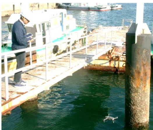
写真 3-5 新技術の活用 （ドローンによる点検）
