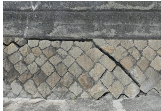
写真2-2 コンクリート構造物の鉄筋露出 写真2-3 構造物の沈下
