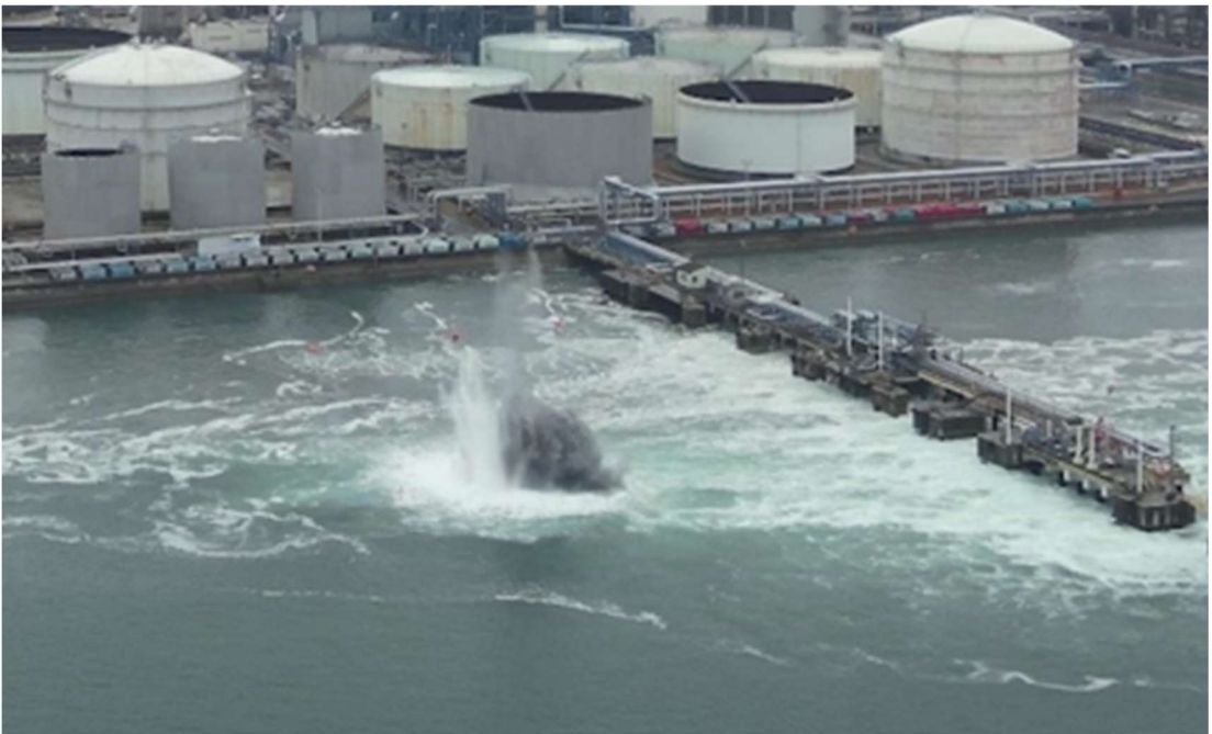
写真-15 爆破瞬間 水柱、振動、爆音あり 市消防本部撮影
