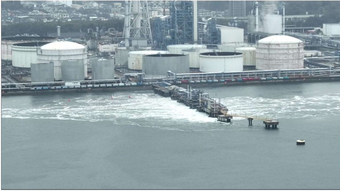
写真-14 バブルカーテン 発生状況：良好 市消防本部撮影
