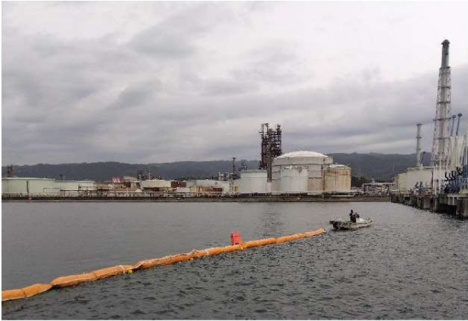
写真-3 バブルカーテン設置作業の様子 (引用元：宇部港湾・空港整備事務所資料)
