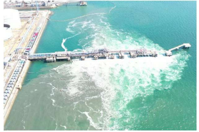
写真-6 バブルカーテン試験運転 (引用元：宇部港湾・空港整備事務所資料)
