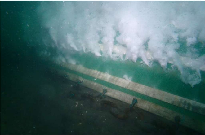
写真-5 水中で気泡が発生している様子 (引用元：宇部港湾・空港整備事務所資料)
