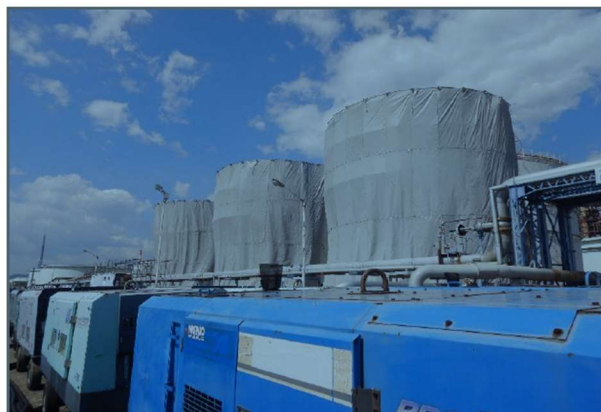
写真-7 防護ネット（引用元：宇部港湾・空港整備事務所資料）
