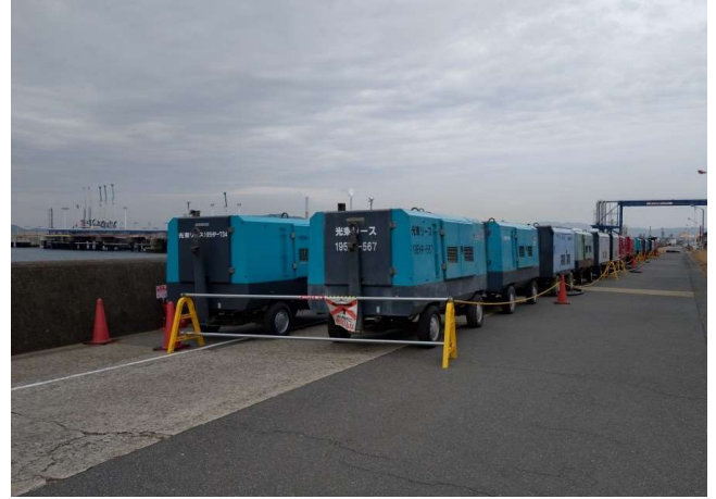
写真-4 コンプレッサー設置状況 (提供元：山口県港湾課)
