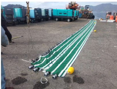
陸上での組立状況
