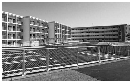
周南第1住宅CDE棟
