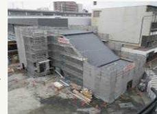
整備が進む自由通路
