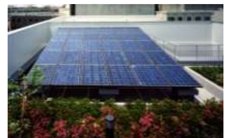
【事例：和歌山県某ビル太陽光パネルの設置】
