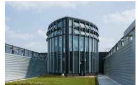
【事例: 愛知県某ビル 自然換気システム】
