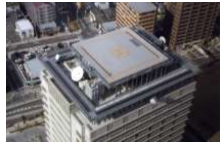
【事例：高松市 ヘリポートの設置】
