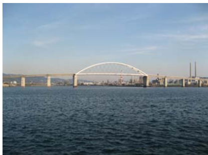
臨海部を結ぶ周南大橋
