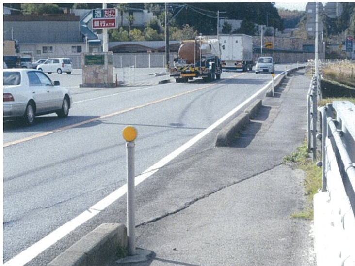
周南市遠見 岩国方面 歩道が狭く、ガードがない P.M 2:00
