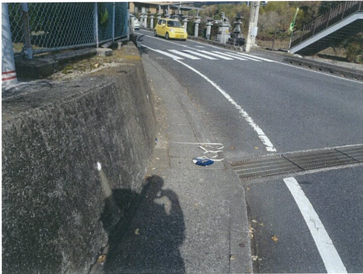
勝間駅前交差点付近
