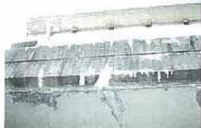
↑ 外壁のコンクリートが老朽
