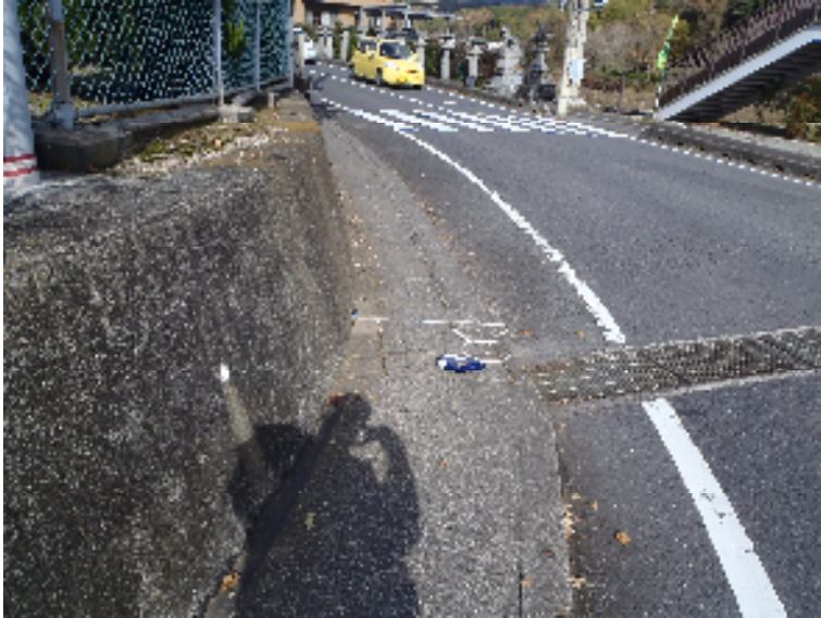
勝間駅前交差点付近
