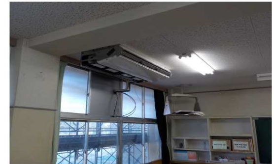
【岐陽中学校普通教室（空調設備設置中）】
