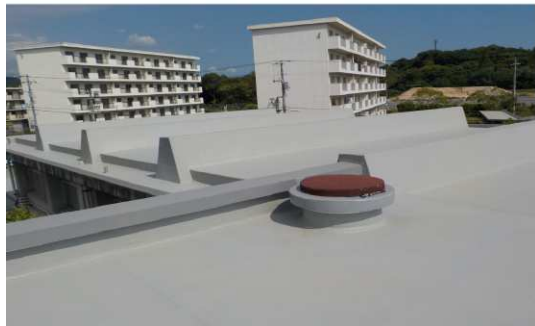
【周陽中学校管理教室棟（防水改修後）】
