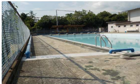
【周陽中学校プール（配管改修後）】
