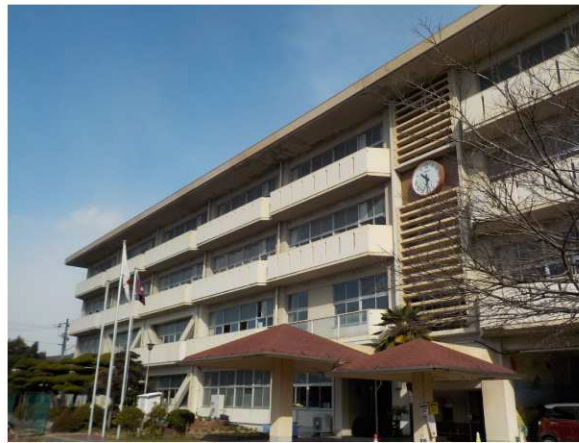
【今宿小学校 管理教室棟（外壁改修前全景）】
