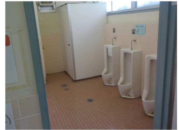
【岐山小学校教室棟（トイレ改修前）】
