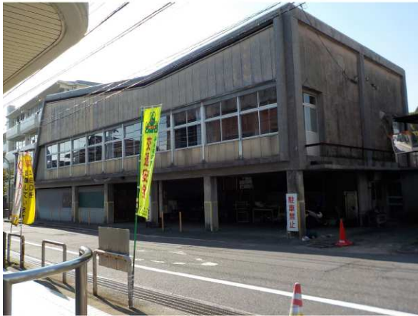
【旧久米支所（解体予定）】
