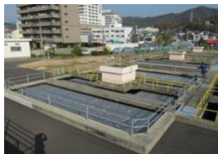
高速凝集沈澱池（大迫田浄水場）
