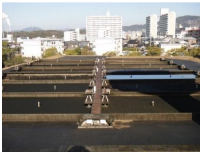
大迫田浄水場の天日乾燥床 (全12床)
