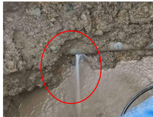
配水管の漏水
