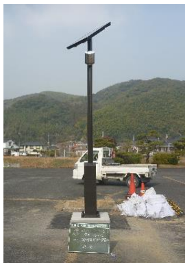
大迫田浄水場及び菊川浄水場の場内照明 (LED照明・太陽光パネル)
