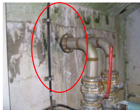
沈澱池 (ひび割れからのエフロレッセンス(白華))
