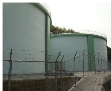
北山配水池 （有効容量 13,000m 3 ）
