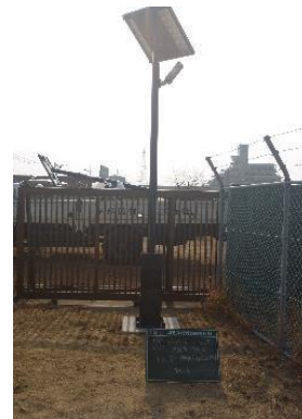
大迫田浄水場及び菊川浄水場の場内照明 (LED照明・太陽光パネル)
