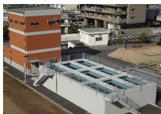
活性炭接触池（大迫田浄水場）
