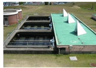
急速ろ過池（大迫田浄水場）
