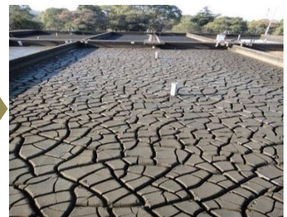
天日乾燥床への汚泥張込み (左)直後、(右)乾燥による減容化
