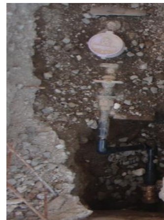
鉛製給水管の解消
