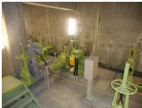
菊川浄水場送水ポンプ (省エネルギーに係る施設・設備)
