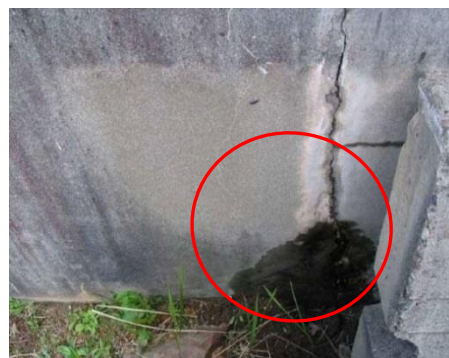
着水井 (ひび割れからの浸潤水)
