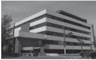
新庁舎建設第1期工事
