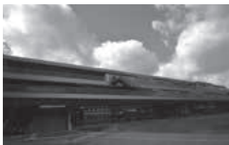
徳山駅前賑わい交流施設の建設
