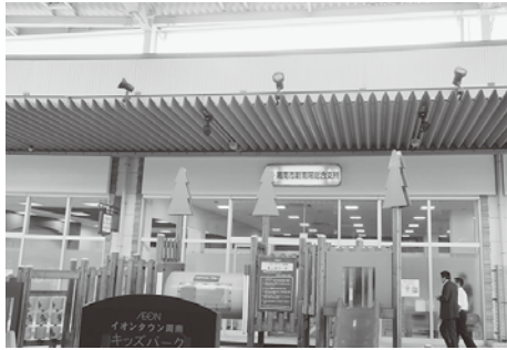
新南陽総合支所仮庁舎
