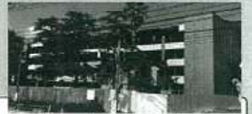
▲解体工事がはじまった新南陽総合支所
