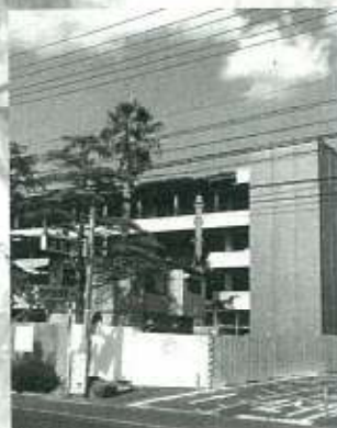
解体が始まった 新南陽総合支所
