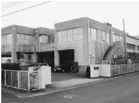
昭和55年に建設された新南陽学校給食センター
