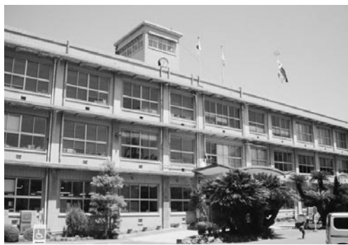
昭和29年に建築された市役所本庁舎本館は、建築後60年が経過
