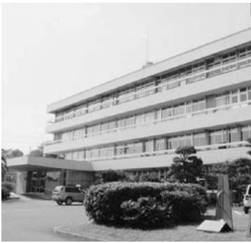
今後整備が予定されている新南陽総合支所
