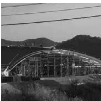
5月のオープンに向けて工事が進む道の駅「ソレーネ周南」
