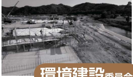
平成26年春のオープンを目指す工事が進む道の駅ソレーネ周南
