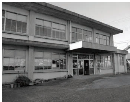
榑浜支所公民館は、築後46年を経過しており、老朽化が進んでいる。
