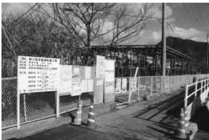
建設中の福川南児童館
