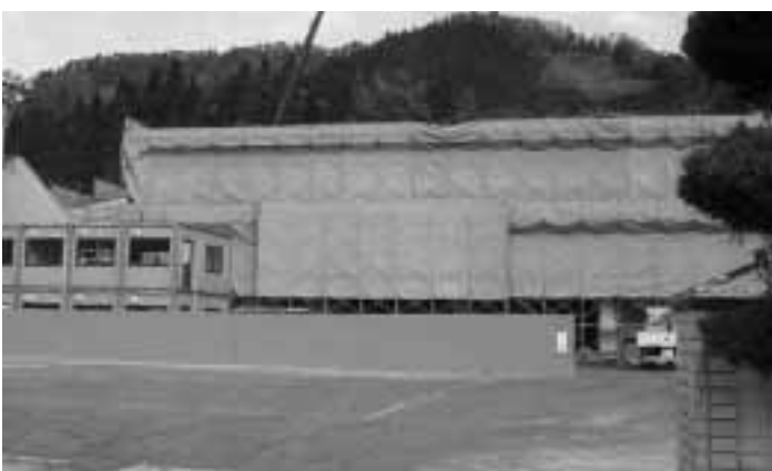
工事が進む大道理小学校体育館
