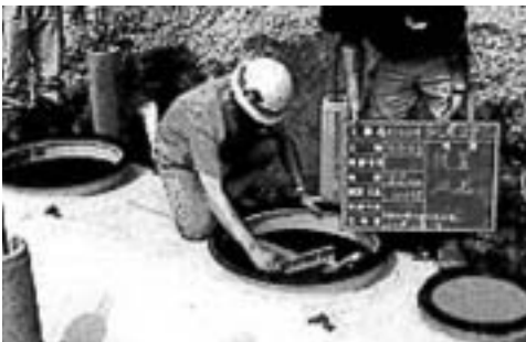
合併処理浄化槽設置工事
