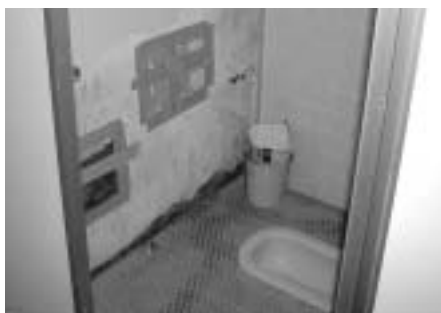
仕切り板に穴があった学校のトイレ
