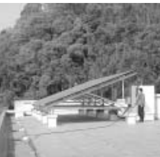
菊川小学校に設置されている太陽光発電設備
