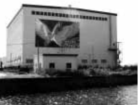
こみ燃料化施設
