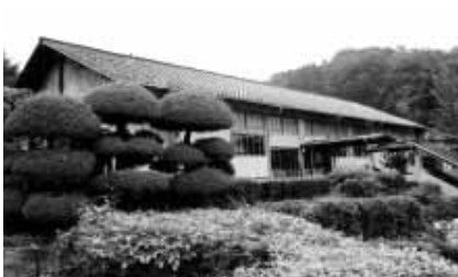
改築が望まれる大道理小学校体育館
