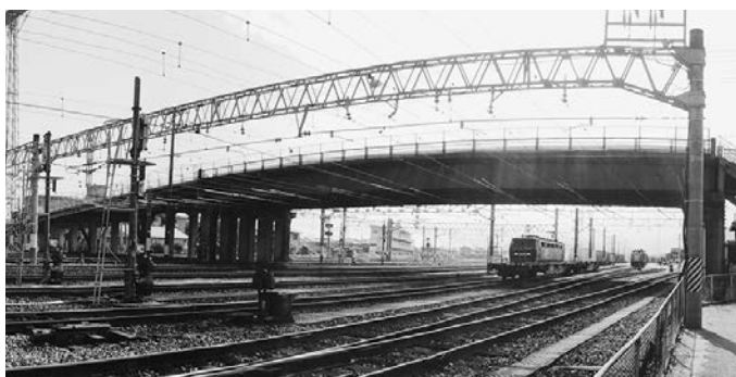
今後架けかえ予定の古川跨線橋
