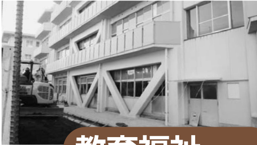
耐震改修工事の進む 今宿小学校教室棟
