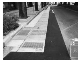
徳山駅北口広場付近浸水対策事業
