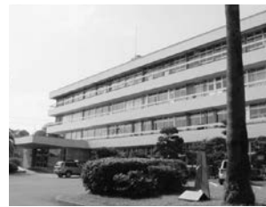
新南陽総合支所
