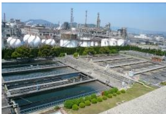
<徳山中央浄化センター>
