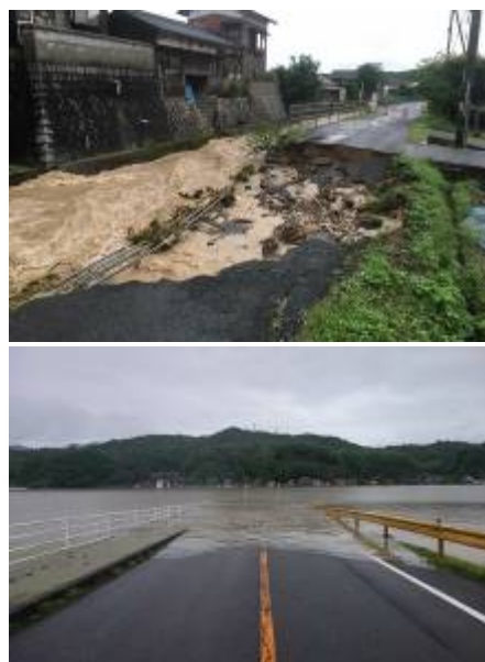
<平成 30(2018)年 梅雨前線による被災現場>
