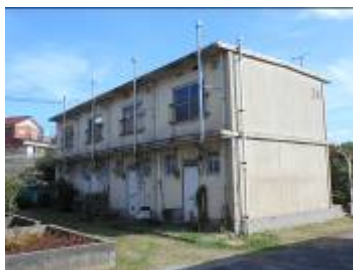
<老朽した市営住宅>
