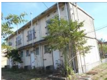
< 老朽化した市営住宅 >
