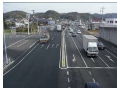
<戸田地区の国道2号>
