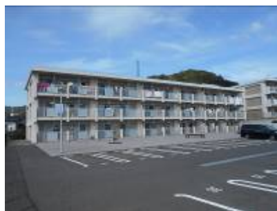
< 建替えられた市営住宅 >
