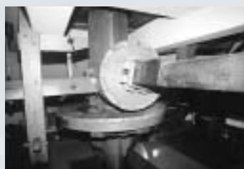
②ホイストフロア 1階から穀物などを吊り上げるための機械があります。また、石うすに動力を伝えるため、歯車のかみ合わせ作業を行います
