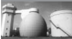
汚泥を使ったタイルが壁に貼られた東部浄化センターのタンク
