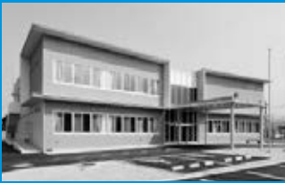
新しくなった櫛浜支所・公民館
