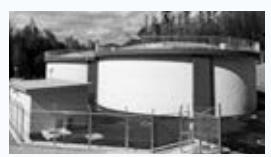
●樋口配水池 容量1,350立方メートル×2池
