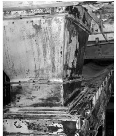
焼け焦げた設備の様子
