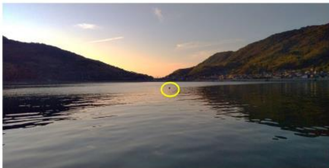
作業後の夕景です。夕陽が沈んでいく中で、設置した標示灯（黄色丸印）が浮かんでいます。
