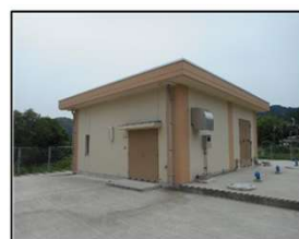
送水ポンプ室 （熊毛地区への送水）
