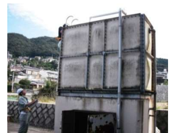
小規模貯水槽の調査
