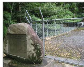
渋川浄水施設
