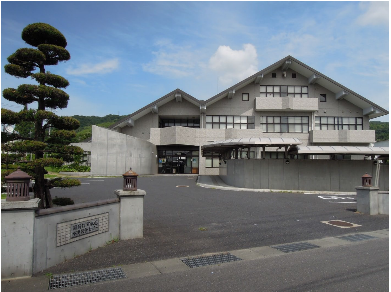
周南都市水道水質検査センター協議会 (周南市、下松市、光市の共同検査施設)
