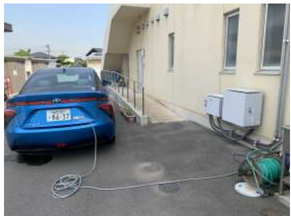
図 17 周南市櫛浜市民センターに整備した給電設備と燃料電池自動車からの給電状況
