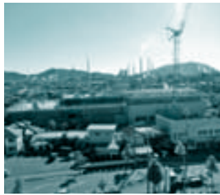
建設中の学び・交流プラザ
