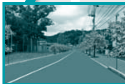
市道宮の前線や、アクセス道の一部をカラー舗装し、快適な空間を整備します
