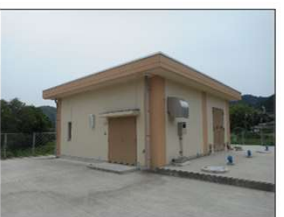
送水ポンプ室 （熊毛地区への送水）
