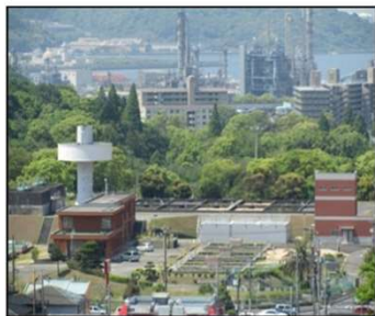
大迫田浄水場
