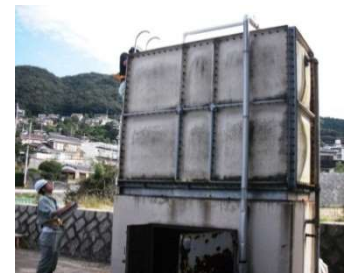
小規模貯水槽の調査
