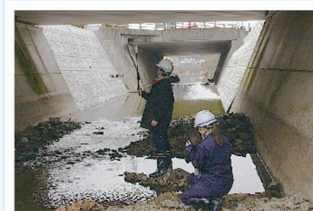
省力化技術の活用により橋を点検する様子(360度カメラとタブレット)
