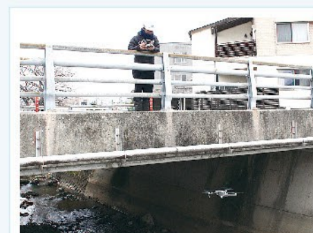
ドローンの活用により橋を点検する様子
