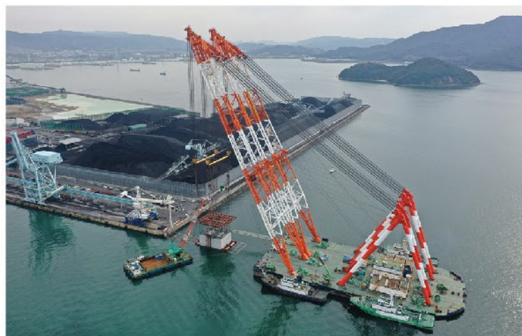
徳山下松港の整備の状況
