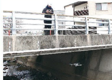
ドローンの活用により橋を点検する様子
