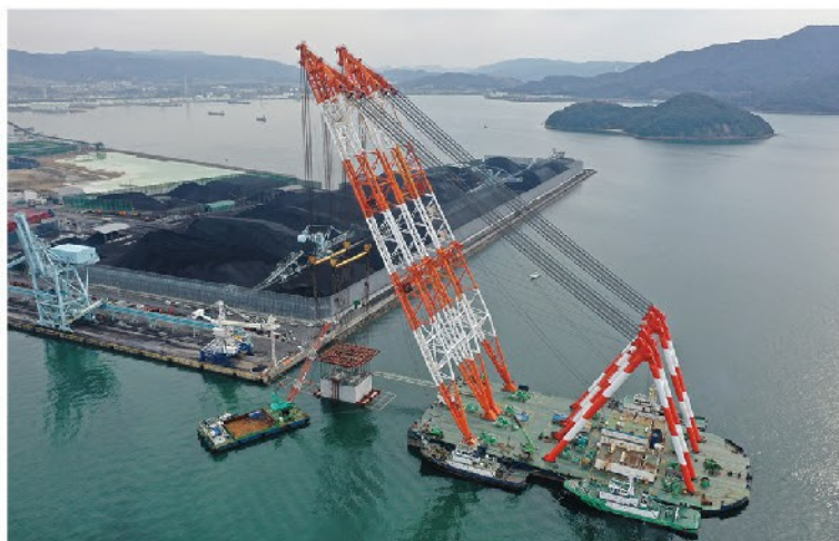
徳山下松港の整備の状況
