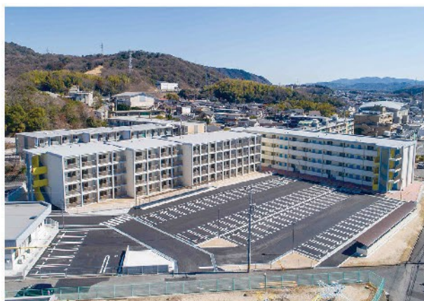
令和4年度に集約建て替えを行った周南第1住宅CDE棟
