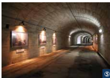
⑤整備工場から回天を運搬するためのトンネル。一部、トロツコが行き交えるよう複線になっている箇所があります。
