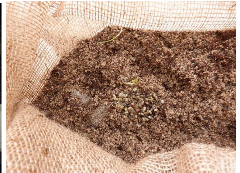
⑤麻袋に腐葉土混合砂、種子、碎石を投入
