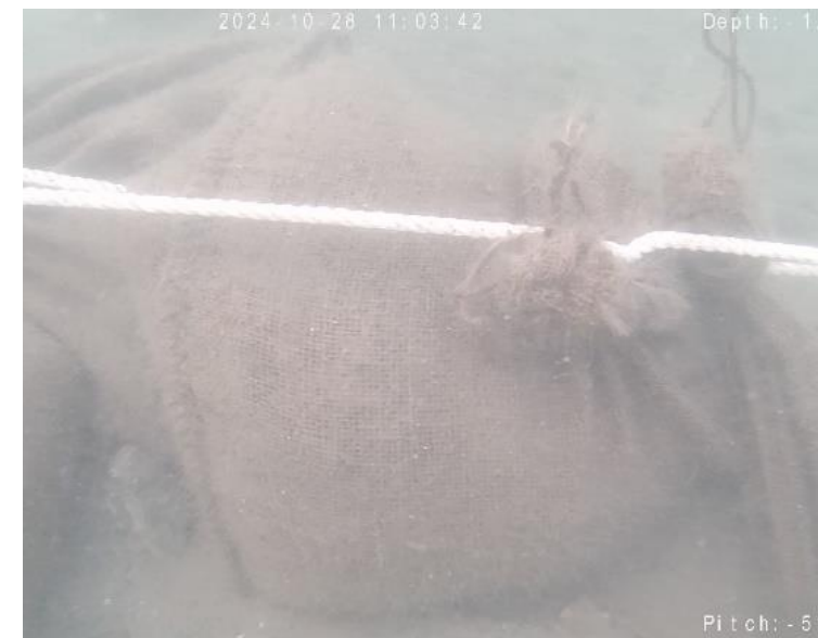
⑧海底の設置状況
