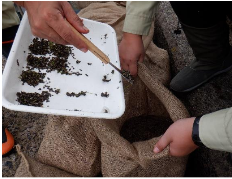
④麻袋に腐葉土混合砂、種子、碎石を投入
