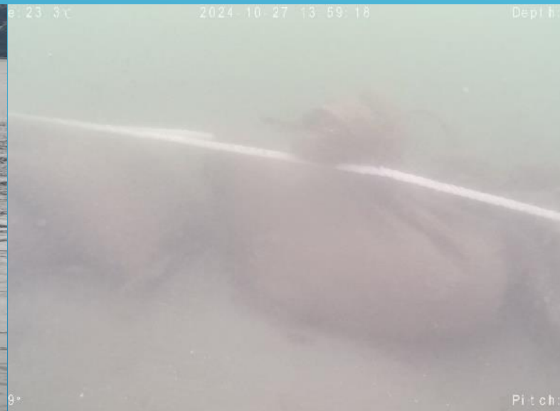
⑧海底の設置状況
