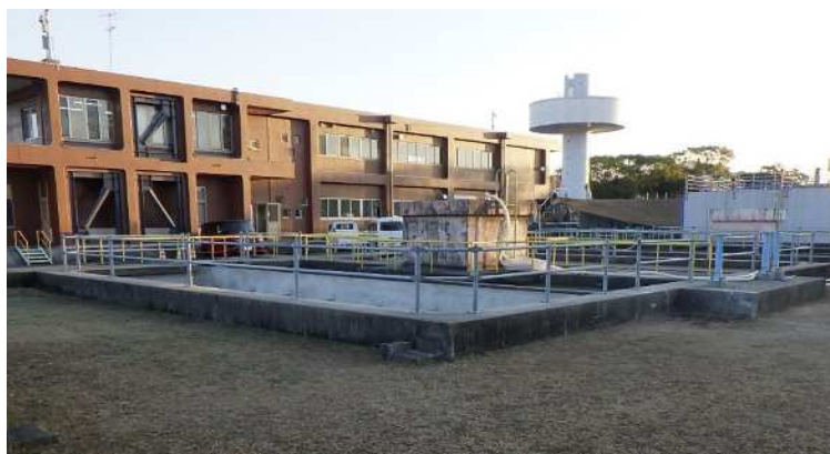
【大迫田浄水場管理棟及び沈殿池】
