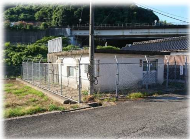
〔戸田山加圧ポンプ所〕
