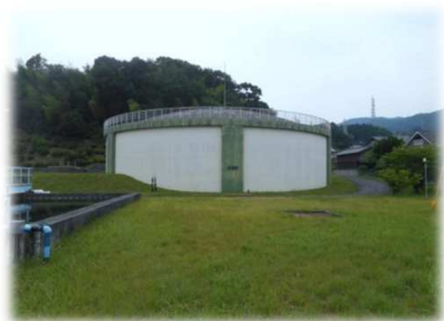
〔一の井手低地区配水池〕
