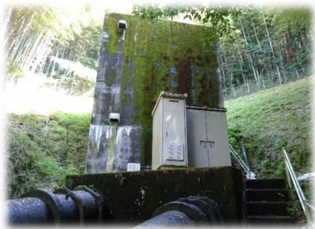
〔平山隧道配水池〕
