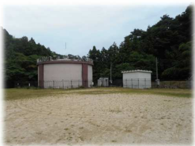
〔赤迫配水池、赤迫ポンプ所〕
