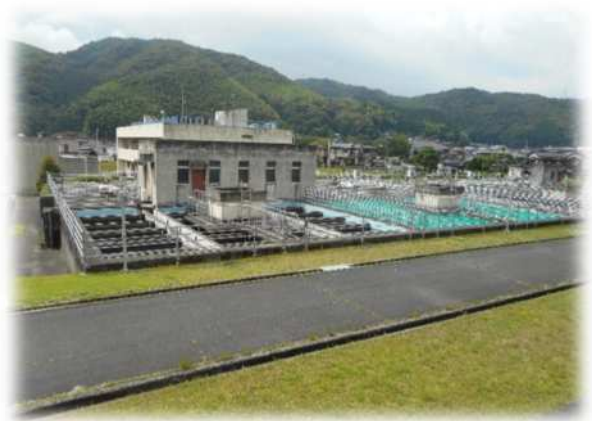
〔高速凝集沈澱池〕
