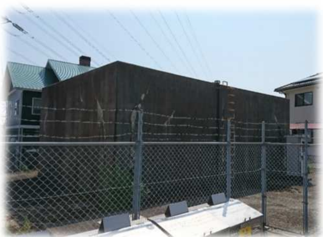
[秋月団地低地区配水池]
