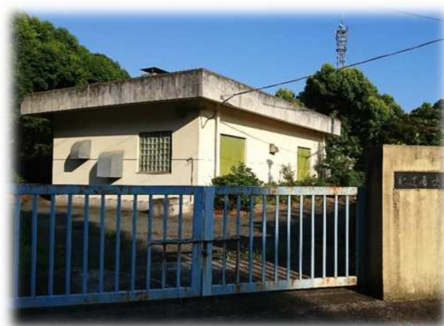
〔長田団地ポンプ所（休止中）〕
