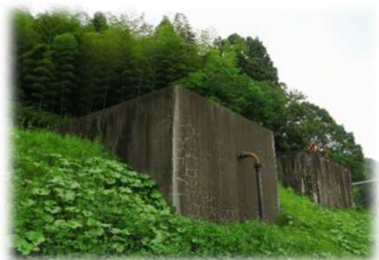
[第1須々万配水池]
