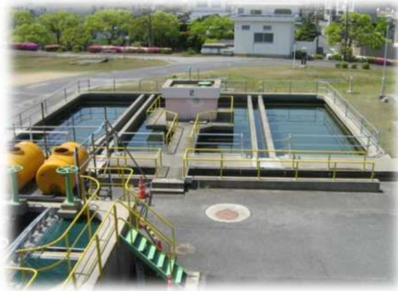
〔高速凝集沈澱池〕
