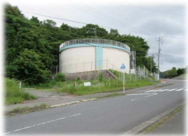
[大迫田東部高地区配水池]
