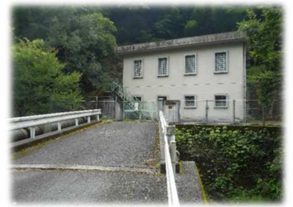
〔中継送水設備 (中山中継ポンプ所)〕
