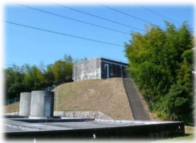
[大迫田高地区配水池]
