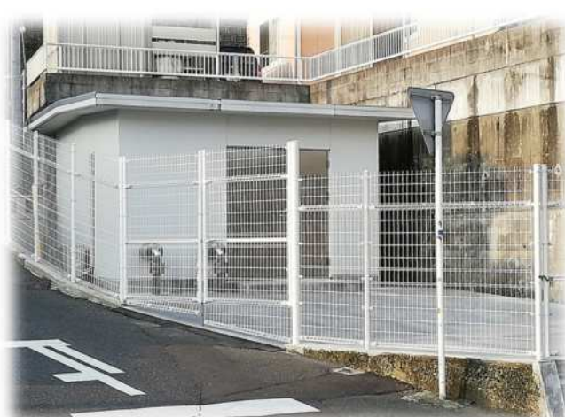
[曙団地ポンプ所]
