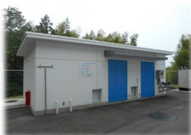
〔次垂注入室（樋口配水場内）〕
