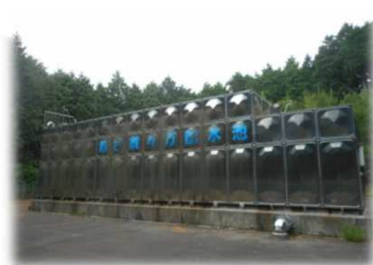
[第2須々万配水池]
