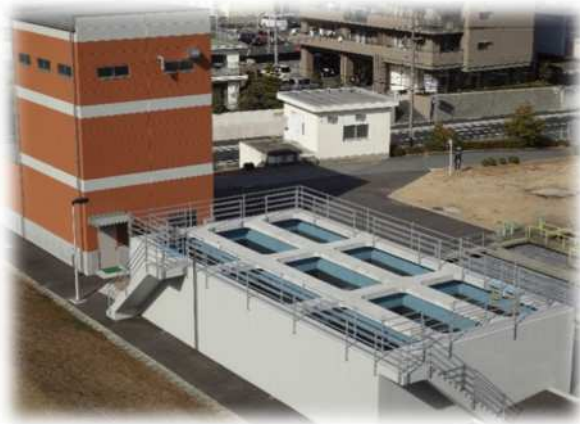
〔活性炭接触池〕
