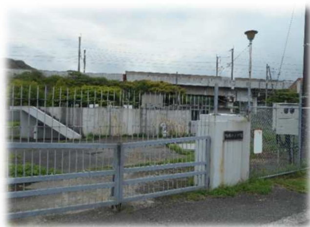
〔的場ポンプ所〕
