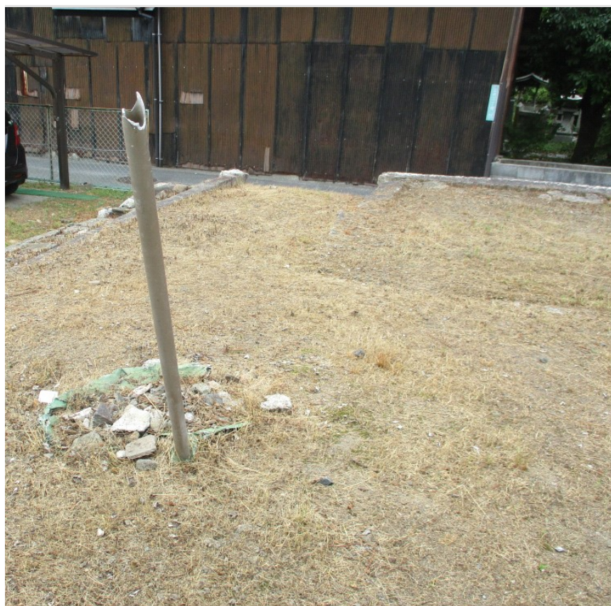
敷地内南東あたりの井戸を埋め戻したような形跡
